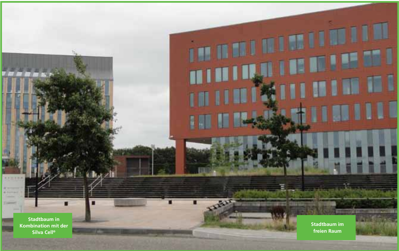
Projekt in Amersfoort (die Niederlande), 5 Jahre nach der Installation von der Silva Cell®
