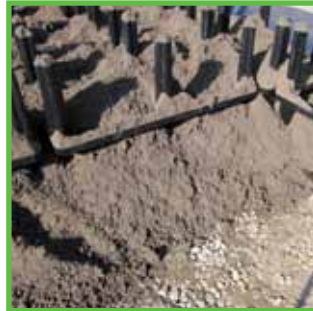
Verfüllung mit Bodensubstraten
