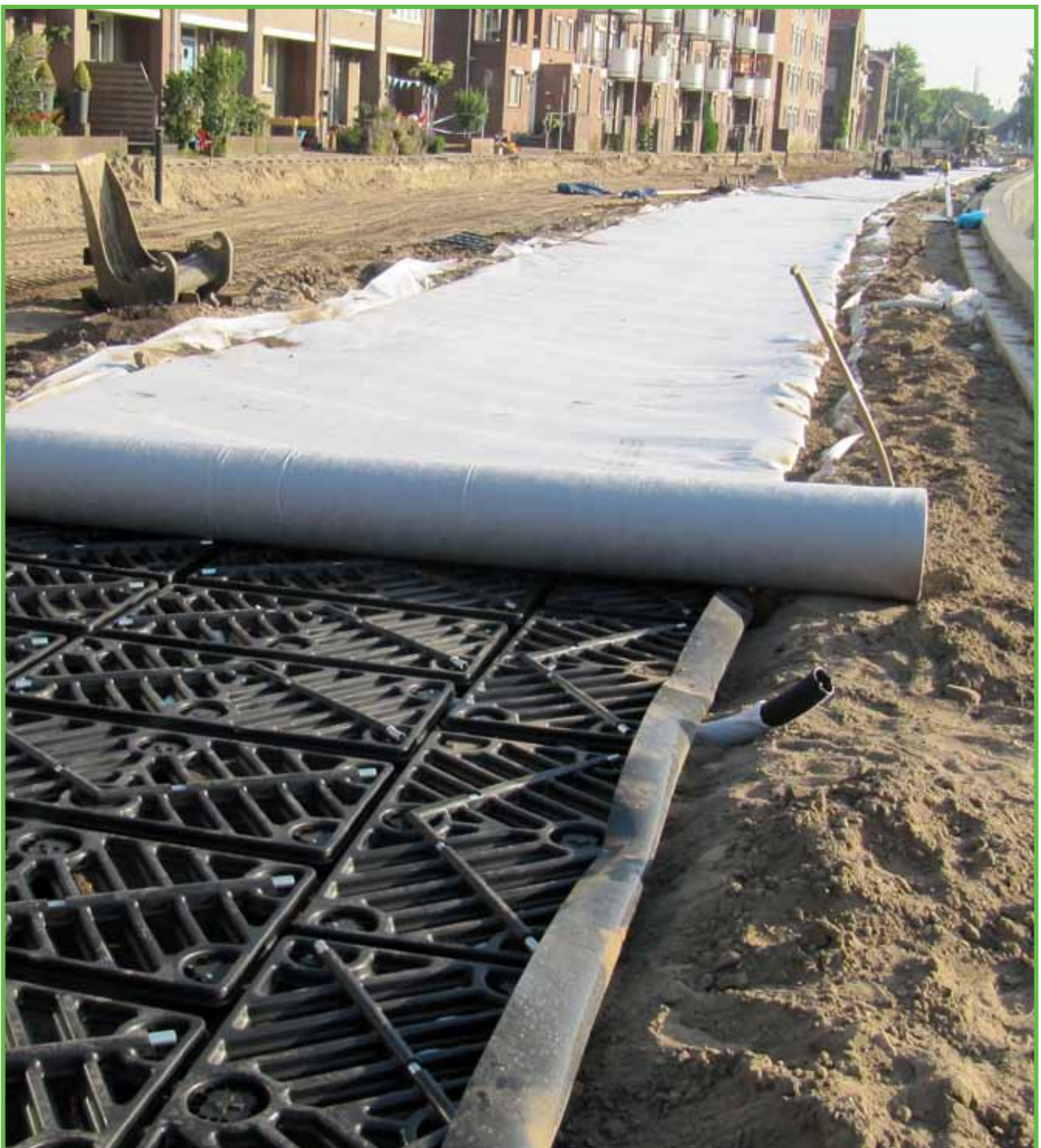
Verfüllung mit Bodensubstraten
